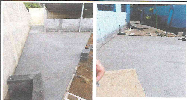
Foto 3: colocación de loza de patio
